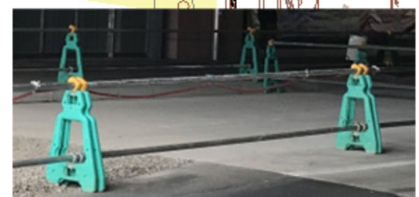
仮囲い：単管パイプ H750
